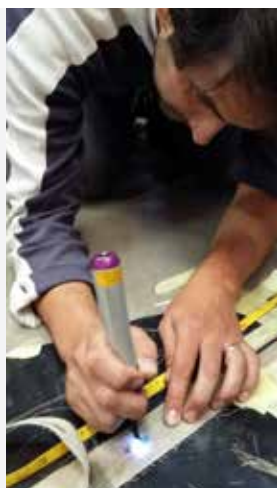
VOORBEREIDING GLASVEZEL- MEETPUNTEN
